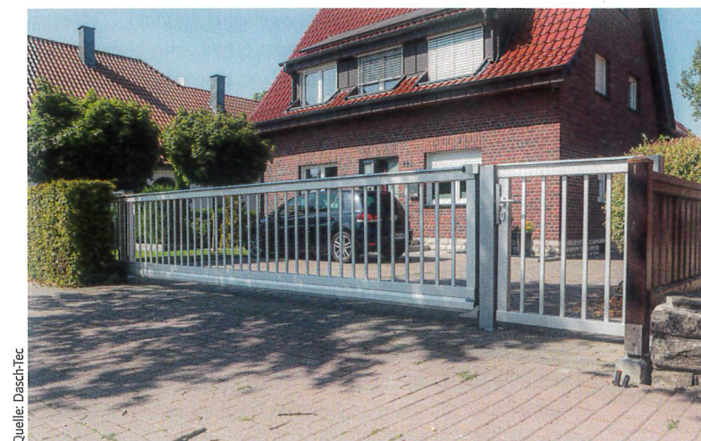
Die fünf Meter breite Schiebetoranlage mit einem Personeneingang wurde in E6 EV1 eloxiert.
